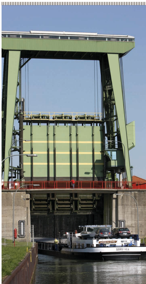
Alte Schleusen wie am Wesel-Datteln-Kanal in Nordrhein-Westfalen erschweren der Branche den Gütertransport. Nicht nur hier sind große Investitionen nötig, wie sich beim Thema „Infrastruktur“ zeigte.
